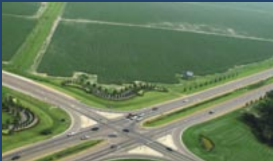
Tunica Metro Mega Site
